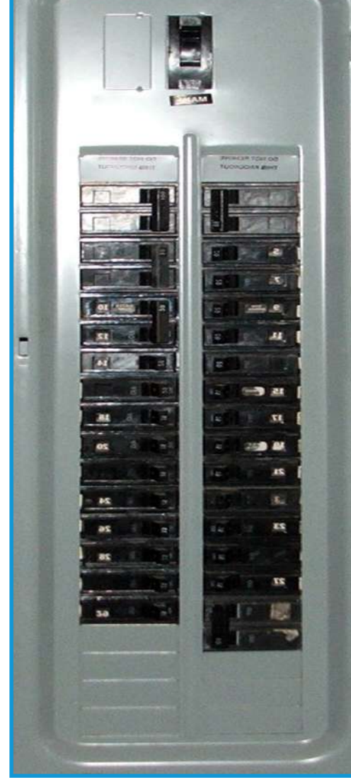
تعمل القواطع على حماية الدوائر الكهربائية من التيارات الكبيرة.
