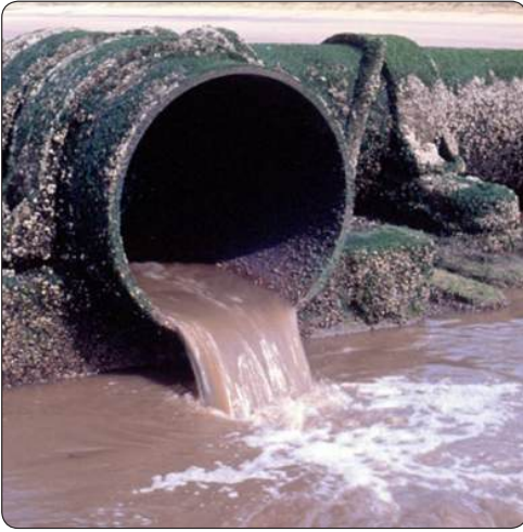
شكل (١١٧) إحدى قنوات الصرف الصحي
