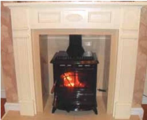
الشكل (٢-٤): الموقد الثابت ذو المدخنة.
